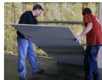
Étape 3 : Soulevez la cloison sèche pour la mettre en place
