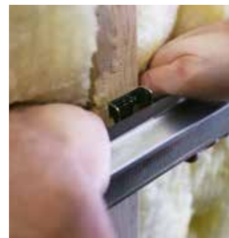
Étape 2 : Enclenchez le profilé oméga dans les clips
