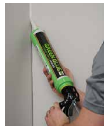
Étape 4 : Comblez les vides entre les cloisons sèches
