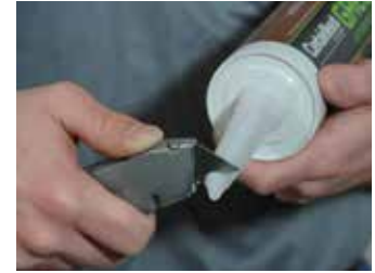
Préparation pour l'application
